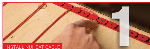
INSTALL NUHEAT CABLE
