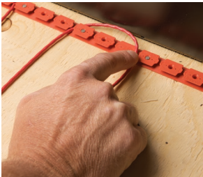
Install Nuheat Cable
