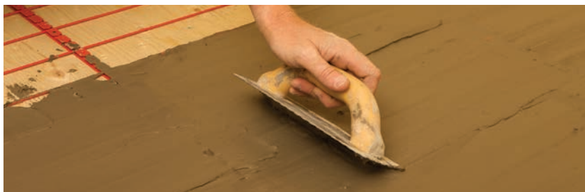
FIGURE 2.52 : Méthode du mortier à pose simplifiée
