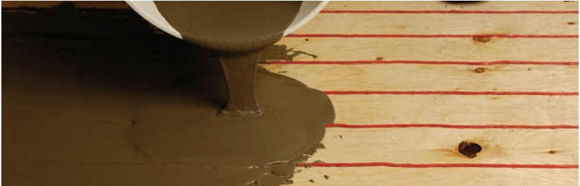
FIGURE 2.42 : Méthode du mélange autolissant
