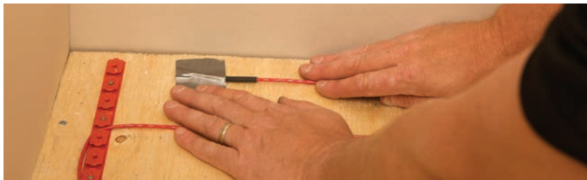
FIGURE 2.28: Fixer l'embout protecteur
