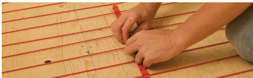
Figure 2.2.9 : Installer les guides de stabilisation
