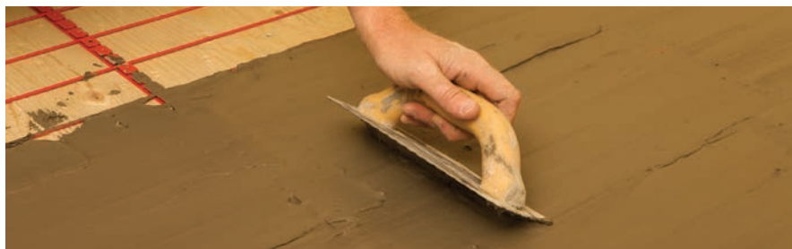
Figure 2.5.2 : Méthode du mortier à pose simplifiée
