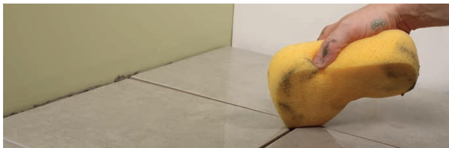
FIGURE 2.23 : Nettoyer les lignes des joints
