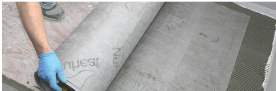
FIGURE 2.13: Placer le tapis sur le mortier mince encore humide
