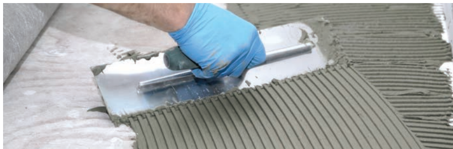
FIGURE 2.12 : Étaler le mortier mince sur le sous-plancher
