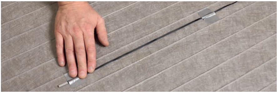
FIGURE 2.16 : Fixer la sonde du capteur de plancher
