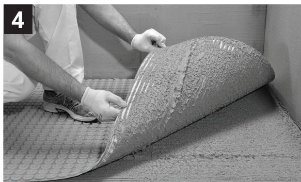
Vérifiez le dessous de la Membrane et assurez-vous que toute la zone est recouverte de béton à prise rapide.
