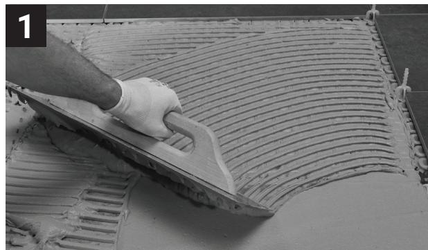
Appliquez une autre couche de mortier sur la partie supérieure à l'aide d'une truelle brettée, adaptée au type et aux dimensions du carreau.
