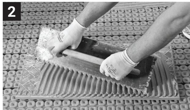
Appliquez du béton à prise rapide à l'arrière du carreau à l'aide d'une truelle brettée. Assurez-vous d'étaler le béton sur toute la surface du carreau, en particulier avec des carreaux de grand format. Posez le carreau sur la Membrane et sur la couche fraîche de béton à prise rapide.
