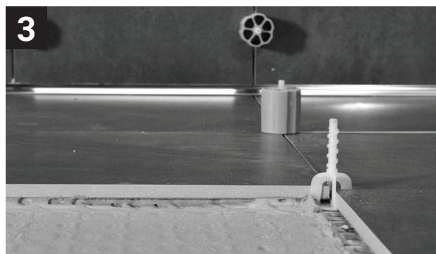
Posez les carreaux avec précaution et appuyez-les sur la couche de béton à prise rapide. Si une couche de peau s'est formée sur le béton à prise rapide, retirez le carreau et appliquez-le de nouveau.
