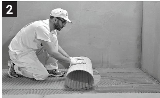
Déroulez la Membrane sur le béton à prise rapide.
