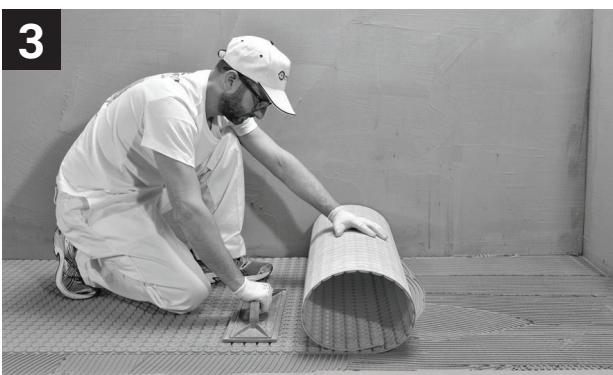
Appuyez sur la Membrane à l'aide d'un rouleau ou d'une truelle plate.
