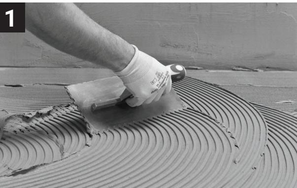
Étalez du béton à prise rapide adéquat sur le substrat à l'aide d'une truelle adéquate.
